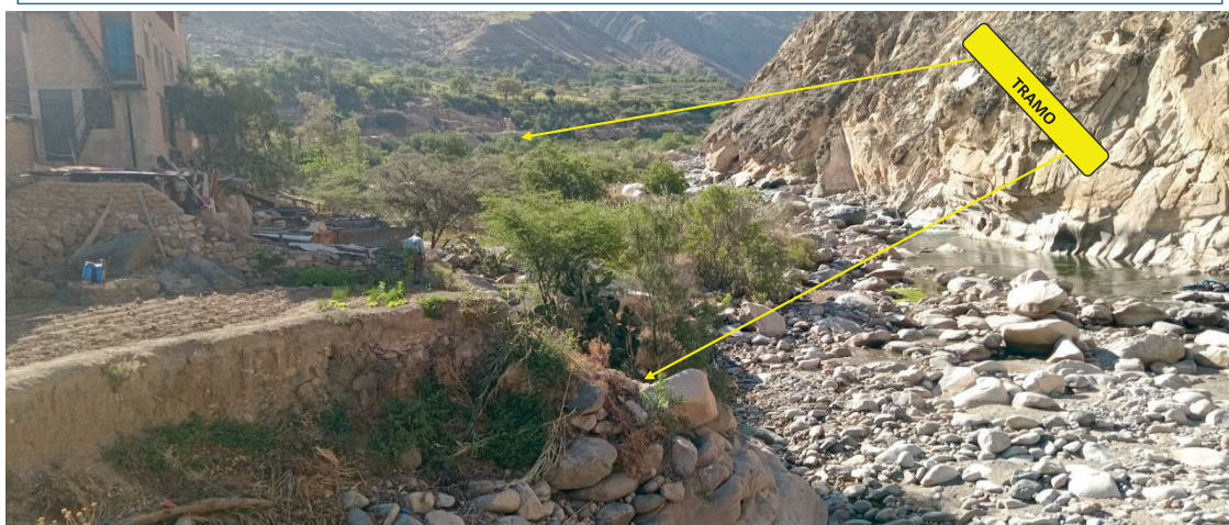
FOTOGRAFIA 02: Tramo crítico en la margen derecha del río San Juan donde se ejecutará limpieza, descolmatación, conformación de dique y enrocado en una longitud de 1,600 m., a fin de proteger esta margen de la acción erosiva del río San Juan.
